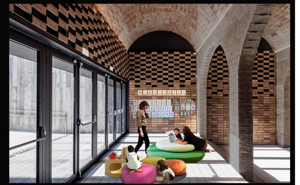
La estructura del edificio original es intervenida y adaptada para convertirse en espacios tipo aula.
