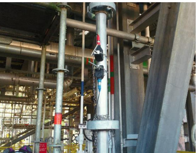
FIGURA 1: BOMBA SW-P-1415 A Y DISPOSICIÓN DE TRANSDUCTORES PARA MEDICIÓN DE CAUDAL.
