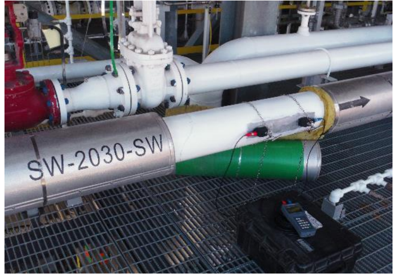
FIGURA 8: DISPOSICIÓN DE TRANSDUCTORES PARA BOMBAS SW-P-1414 A/B
