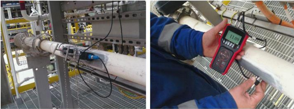
DISPOSICIÓN DE TRANSDUCTORES Y MEDICIÓN DE ESPESOR DE BOMBA SR-P-1312 B
