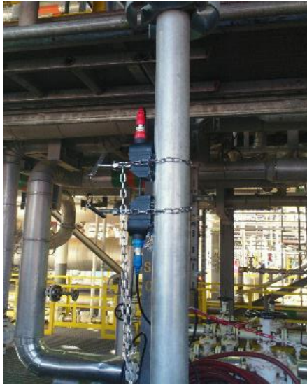
FIGURA 7: DISPOSICIÓN DE TRANSDUCTORES PARA BOMBA SW-P-1415 B
