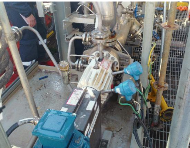
FIGURA 5: BOMBA GA-P-313 A Y DISPOSICIÓN DE TRANSDUCTORES PARA MEDICIÓN DE CAUDAL DE LA MISMA
