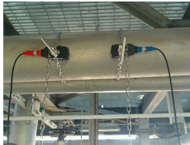
FIGURA 5: BOMBA GA-P-313 A Y DISPOSICIÓN DE TRANSDUCTORES PARA MEDICIÓN DE CAUDAL DE LA MISMA
