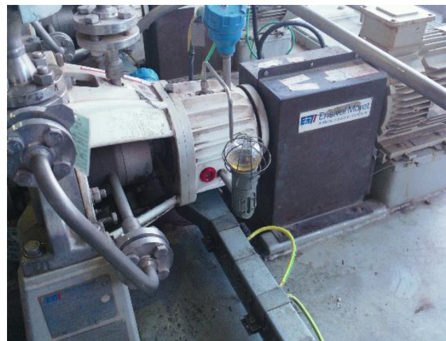
FIGURA 1: BOMBA SW-P-1415 A Y DISPOSICIÓN DE TRANSDUCTORES PARA MEDICIÓN DE CAUDAL.
