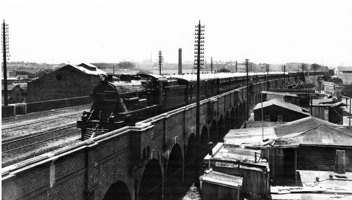
La traza elevada ya con la "nueva" Estación Hipólito Yrigoyen establecida. (1928)
