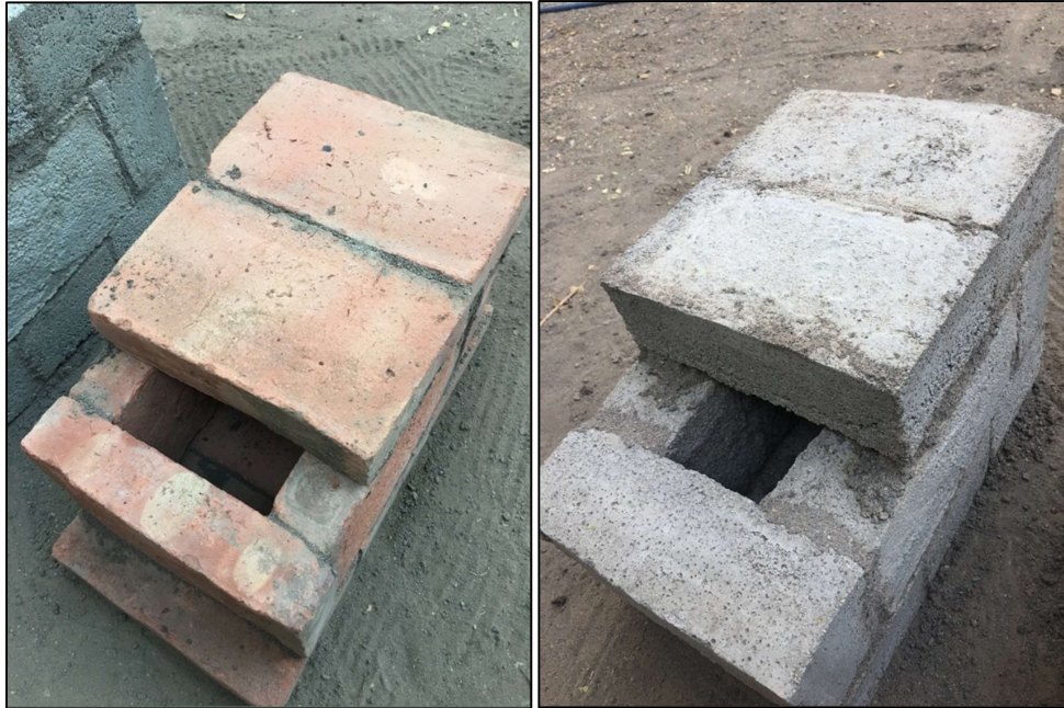
Imagen: Perspectiva cámara aislante ladrillo/bloque.
