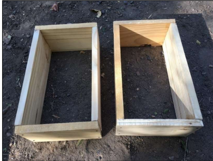
Imagen: Moldes terminados.
