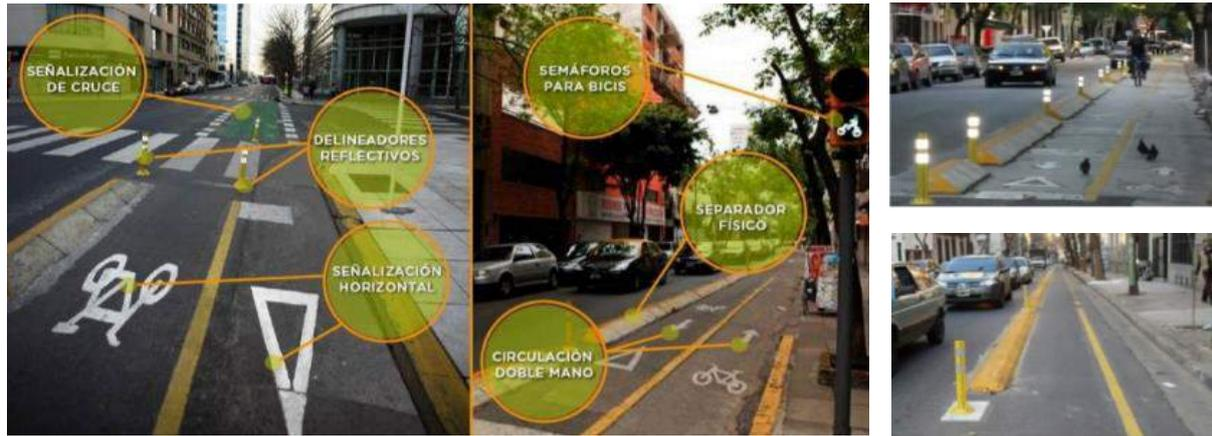
Fig. 21. Características de diseño. / Fig. 22 y 23. Cordón alto y bajo, extraídos de “Anexo V: Lineamientos generales ciclovías y bicisendas”, p. 8 y 9.
