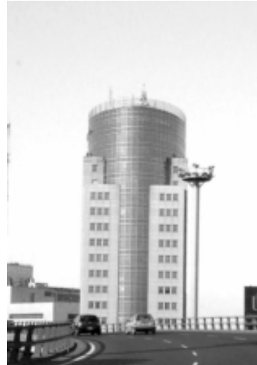
18. Edificio Panamericana Plaza / Panamericana Plaza building Lier y Tonconogy, 1995
