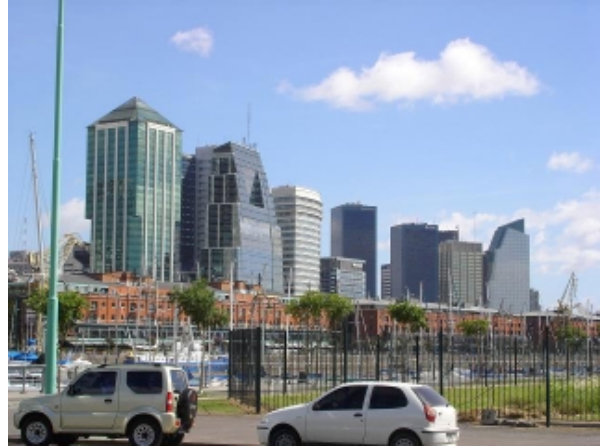
10. Barrio Catalinas Norte / Catalinas Norte district.
