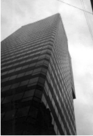
9. Edificio San Martín 344 / San Martín 344 building Mario Roberto Álvarez y Asoc., 2001
