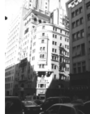
30. Jousten Hotel (Hotel, Cherzanaz y Pérez Irigoyen, 1928) Rehabilitación / Rehabilitation Urgell, Fazio, Penedo, Urgell, 1998
