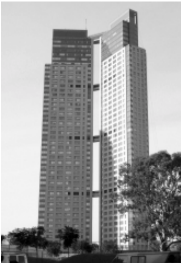
35. Torres El Faro / El Faro Towers Dujovne, Hirsch, en construcción / under construction
