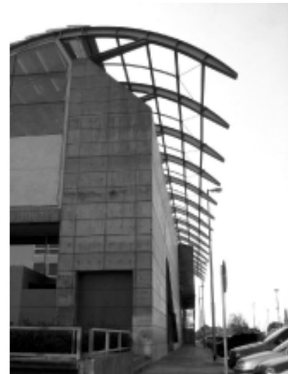
16. Museo Fortabat / Fortabat Museum Rafael Viñoly, en construcción / under construction
