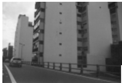
Autopista y autopistas: los no lugares se multiplican.
