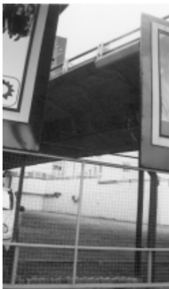
Espacios bajo la Autopista Central . Bs. As.
