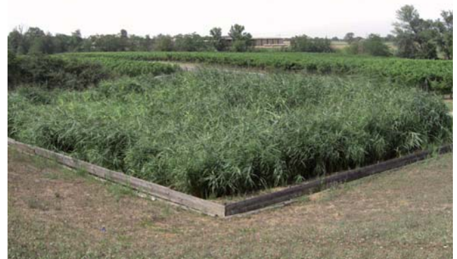
Ejemplo planta fitodepuración en Toscana (Italia) 10 Esempio di impianto di fitodepurazione in Toscana (Italia) 10
