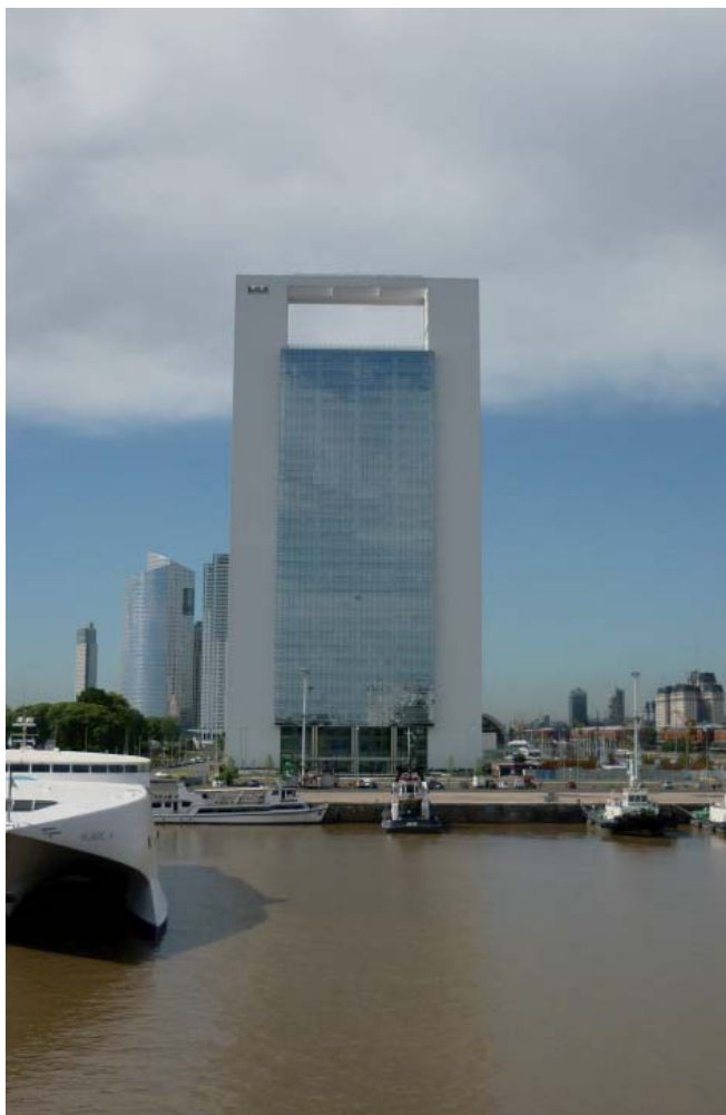
Vista edificio 40 Vista edificio 40
