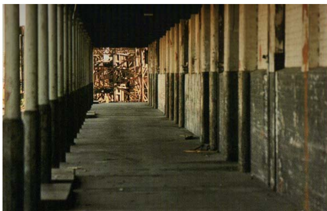
Foto de uno de los edificios antes de la intervención 21 Foto de uno degli edifici prima dell'intervento 21
