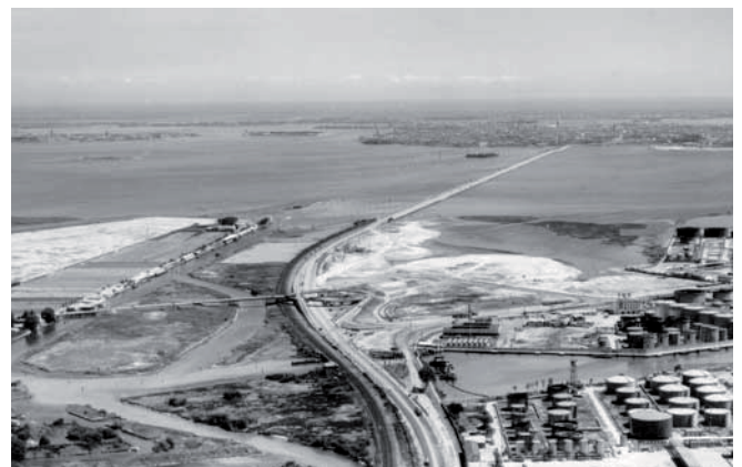
Foto de la construcción de almacenamiento de productos petroquímicos 5 Foto costruzione depositi petrolchimico 5
