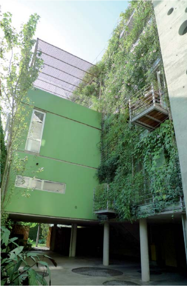
Vista patio edificio 28 Vista patio edificio 28
