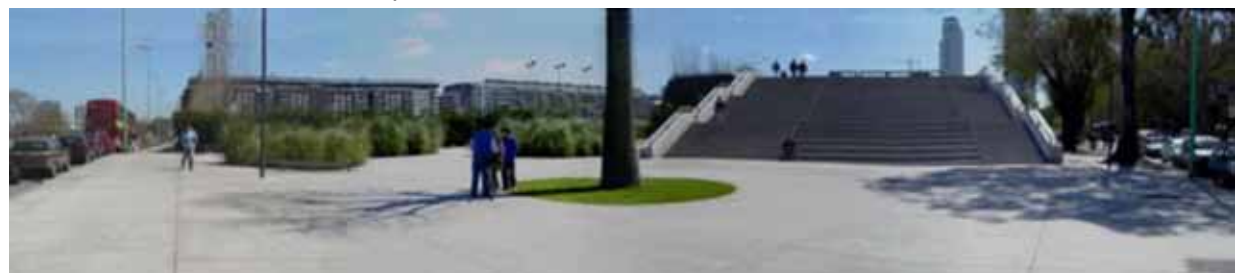
Imágenes de Pisos de Cemento Alisado utilizados en el Parque Micaela Bastidas
