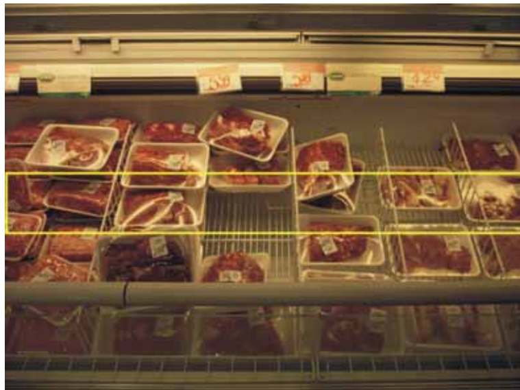
Figura 13: Sector dentro de la heladera tipo 2 donde los productos poseen mayor probabilidad de presentar temperaturas más elevadas.
