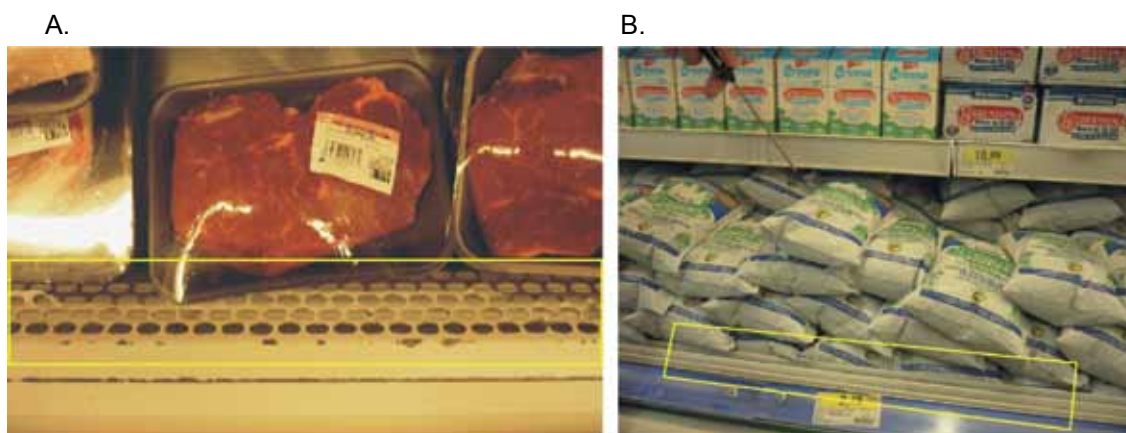
Fig. 9A y B. Los recuadros destacan las rejillas de los bordes inferiores delanteros de las heladeras.
