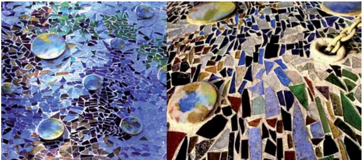
Figuras 19 y 20 - Detalle de los cerámicos de la fachada.
