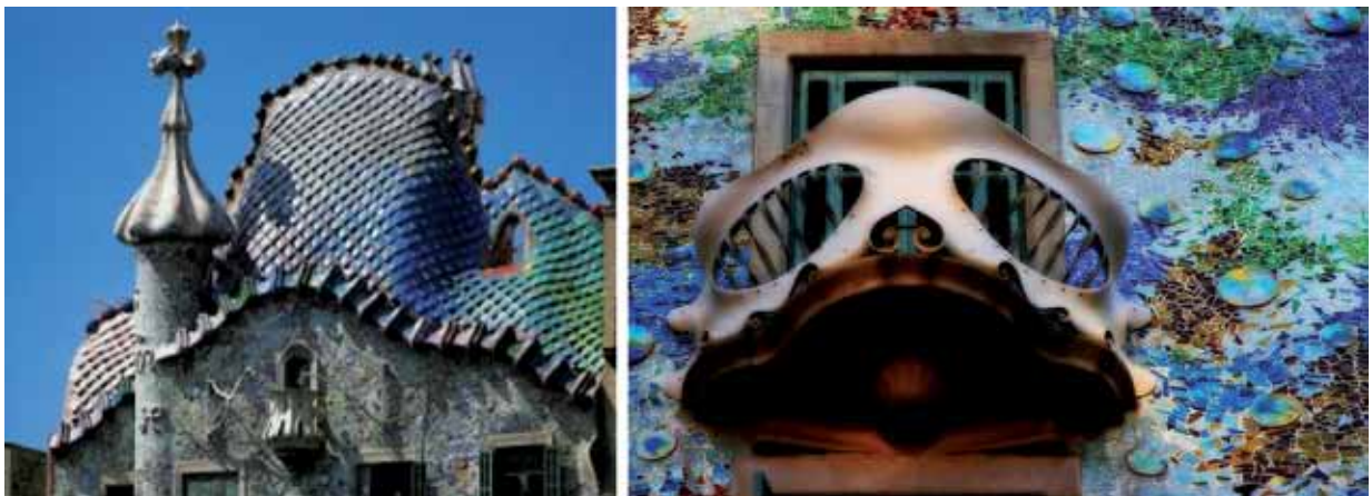
Figuras 7 y 8 – A la izquierda, una vista del techo, desde el frente del edificio. A la derecha, detalle del balcón de hierro con características medievales y fachada revestida de cerámica vidriada.
