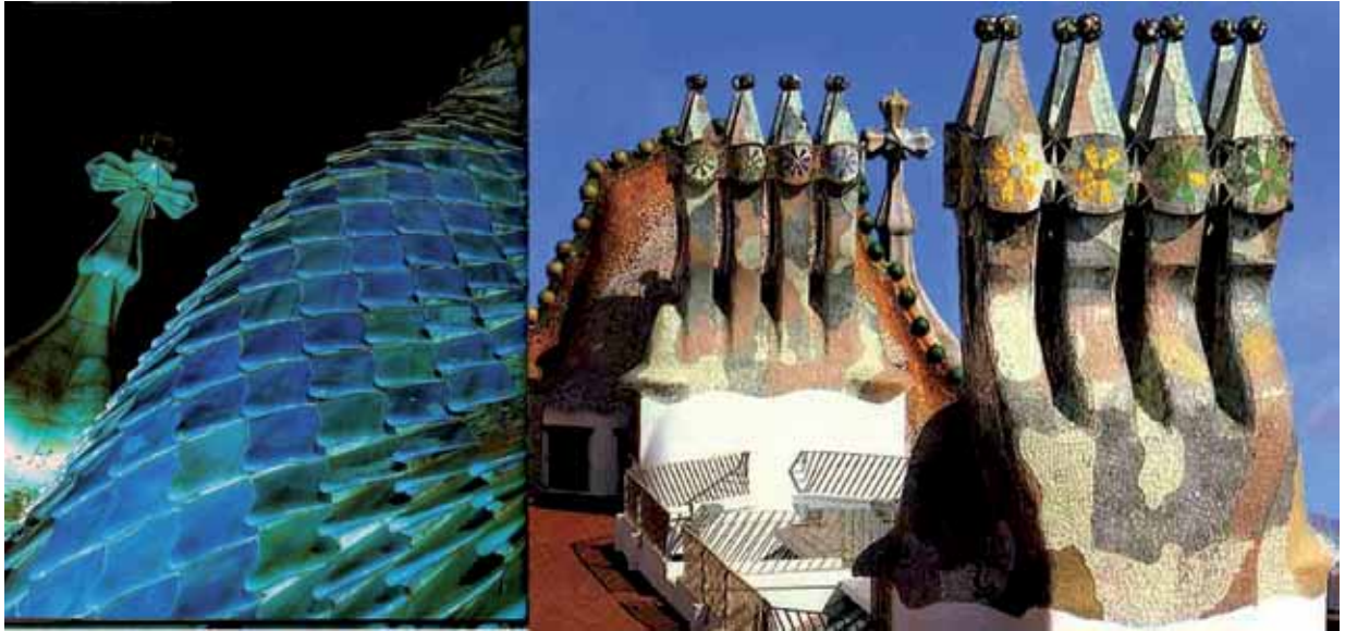
Figura 17 y 18 – Cerámicas de vidrio en el techo y en las chimeneas en la terraza.
