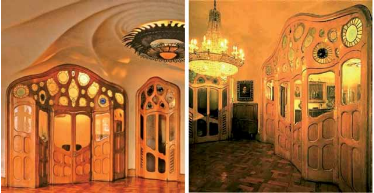
Figuras 24 y 25 - Separación del Salón Batlló. Madera de roble y cristal
