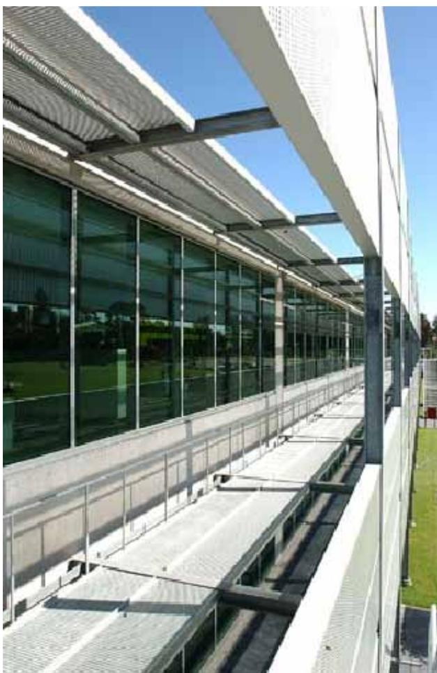
Este tipo de fachadas ventiladas presenta un excelente comportamiento frente a los agentes atmosféricos y produce un ahorro energético en acondicionamiento térmico del edificio que se ha estimado entorno al 20% y 30% sobre otros acabados convencionales.
