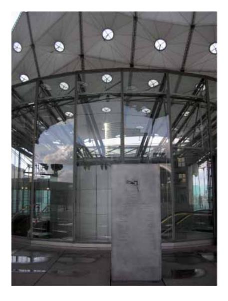
En el centro del Arco, en su hueco interno, se pueden ver dos elementos formales: el bloque de ascensores, contenido dentro de una estructura metálica, y "les nuages", un pabellón con cubierta de vidrio sostenido por cables de acero tensados, obra de Paul Andreu<sup>23</sup>, el arquitecto que termino la obra una vez fallecido Otto Van Spreckelsen<sup>24</sup>.
