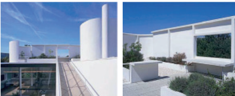
Vistas de la rampa que conduce a la cubierta y de la cubierta-solarium
