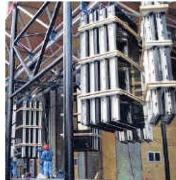
2º colocación de los elementos de cierre
