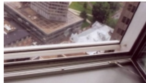
Ventana de las oficinas periféricas
