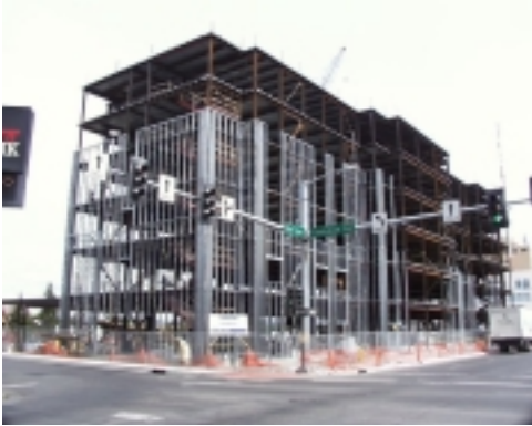
1º colocación de estructura
