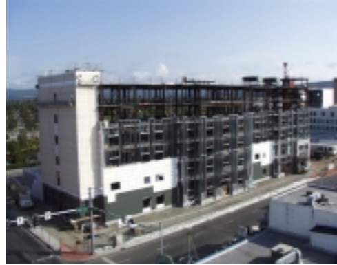
2º colocación de los elementos de cierre
