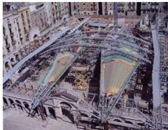
Armado de la cubierta del mercado de Santa Caterina/ Barcelona/ Estudio EMBT
