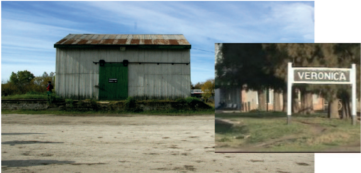
Antiguo cartel que anuncia la llegada a la estación ferroviaria de Verónica junto con uno de los galpones de la estación/ Pre existencias/ Año 2010
