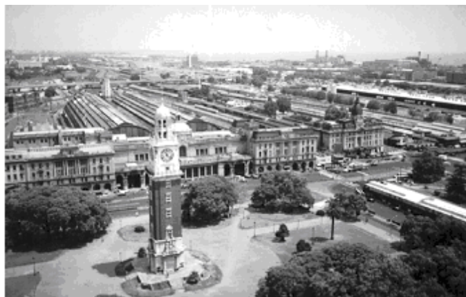
Terminales de trenes de Retiro / Retiro train terminals
