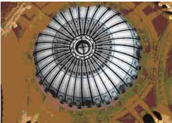
Fig. 103. La cúpula central, sus gajos metálicos. (Autora)
