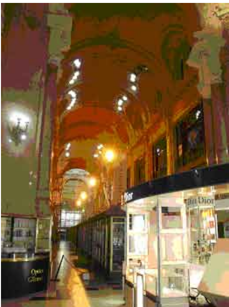
Fig. 97. La bóveda de la galería Güemes. (Autora)
