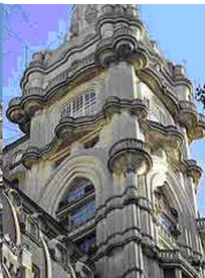
Fig. 33. Idem anterior, particular de la torre. (Pont des Arts)
