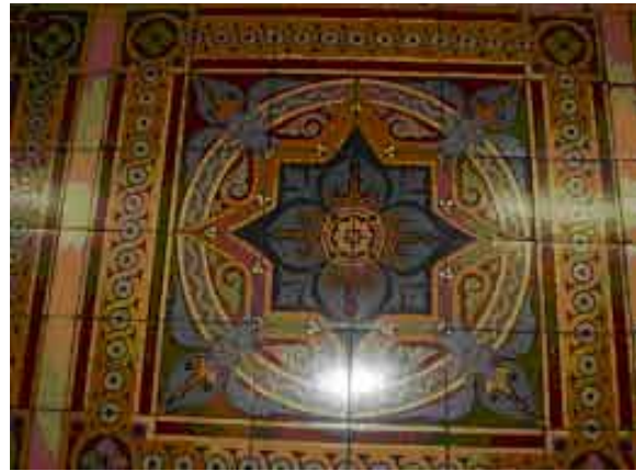
Fig. 54. Detalle de los solados del Congreso. (Autora)
