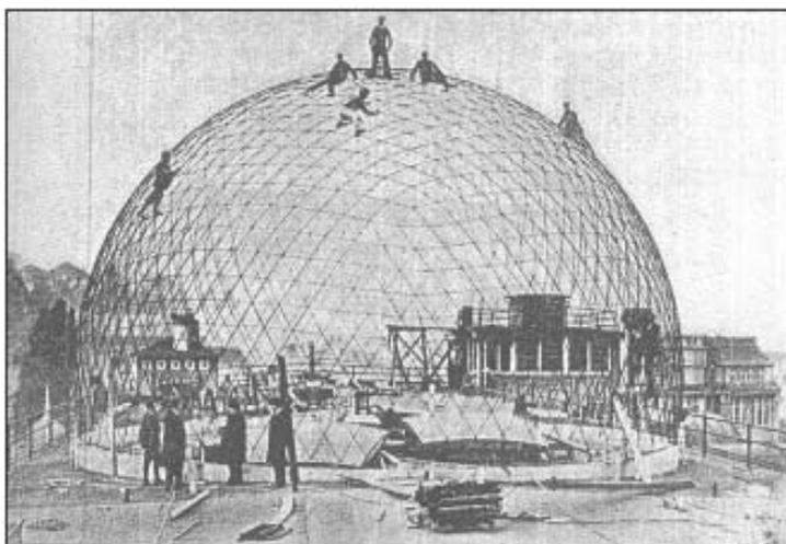
Fig. 35 - Esqueleto inicial de la cúpula realizada por Dywidag para la Zeiss.
