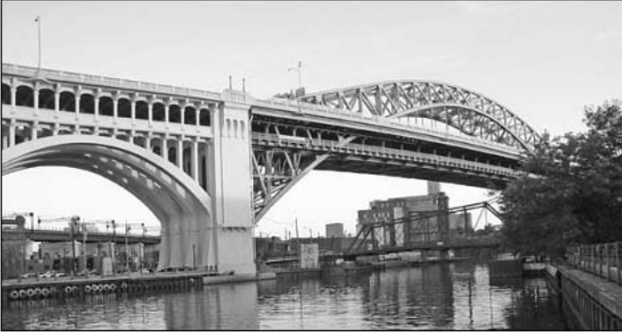
Fig. 2 - Superior Bridge, Detroit, Michigan, USA. Arcos que sustentan el puente: las fuerzas son transmitidas de la estructura hacia el terreno a través de un canal definido por la forma.
