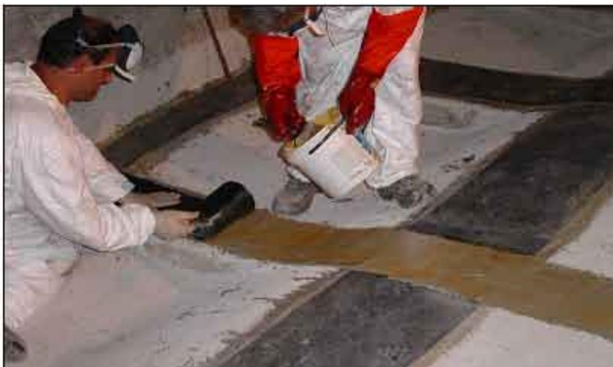
Fig. 90a - El tejido viene colocado sobre la primera capa de resina.
