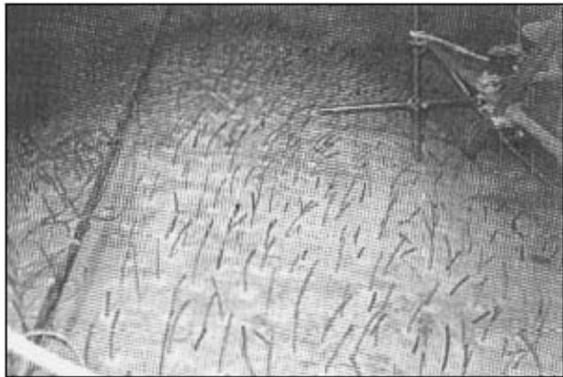
Fig. 81 - Tubos para las inyecciones en las bóvedas de la Basilica de San Francesco en Assisi.
