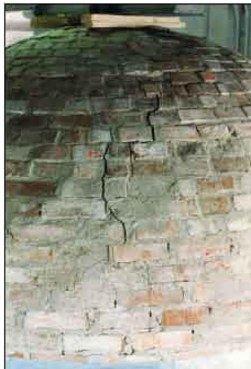
Fig. 95 - La fisuración a lo largo de los meridianos de una cúpula en mampostería reforzada con tejidos en FRP a la base.
