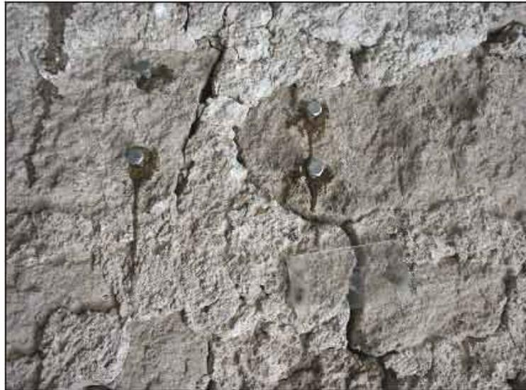
Fig. 67 - Indicador en vidrio y bases para el deformómetro, aplicadas sobre un bloque suficientemente resistente.
