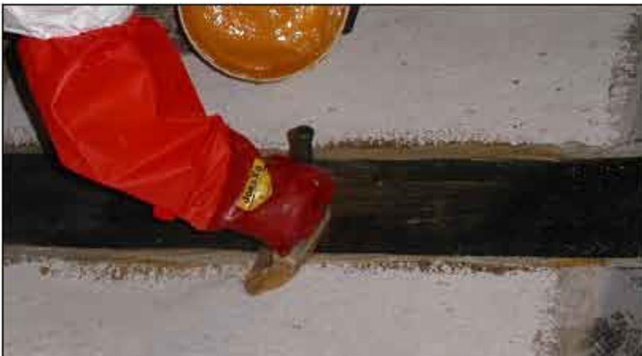
Fig. 90a - Se aplica una segunda capa de resina.
