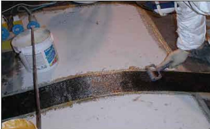
Fig. 90b - Viene pasado un rulo para eliminar las burbujas de aire.
