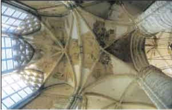
Fig. 57 - Manchas de humedad al intrados de una bóveda.
