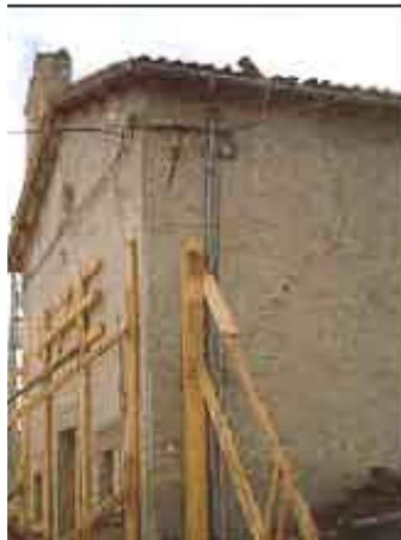
Fig. 58 - Tendencia a girar de una fachada: se nota una fisura diagonal sobre la pared lateral.
