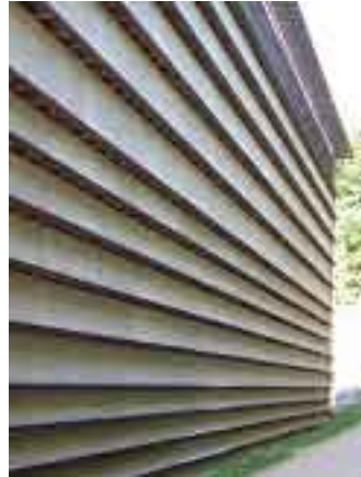
Vistas del Almacén de Ricola . Muestran en toda su extensión unos tablonces horizontales con anchuras diversas, cada vez menores, que crean una sensación de profundidad.
