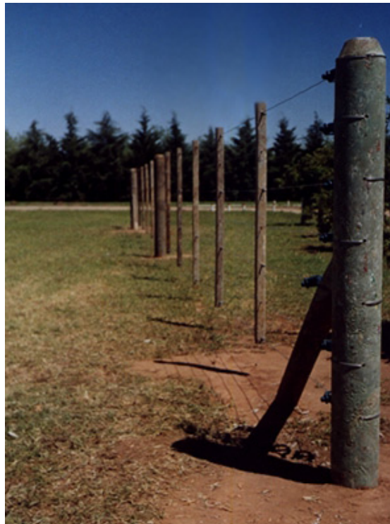
Foto 5.3 Alambrado de un campo con postes de madera plástica.
