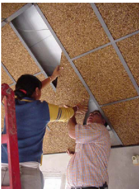
Foto 5.7. Colocación de las placas para cielorraso con cáscara de maní
