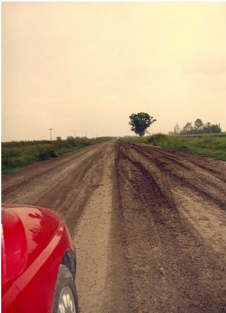
Estado actual Camino II
