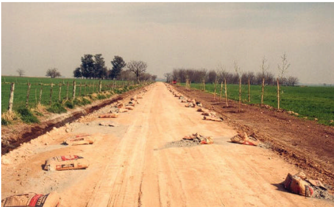
Distribución y cortado de las bolsas de Cemento sobre el camino
