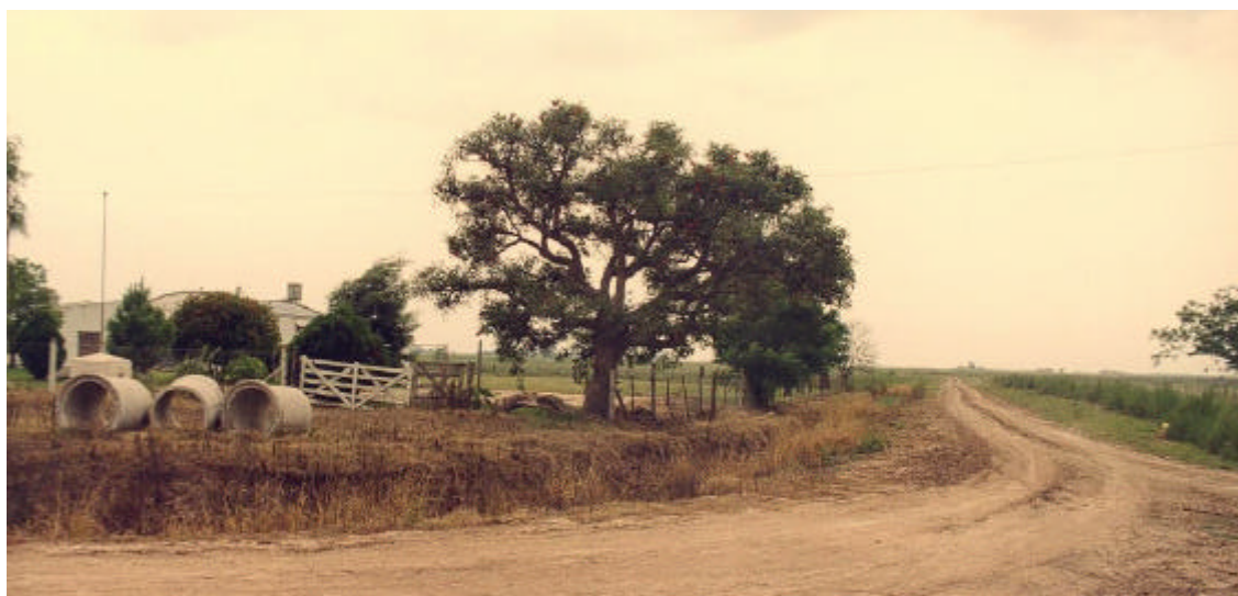
Estado actual Camino I
