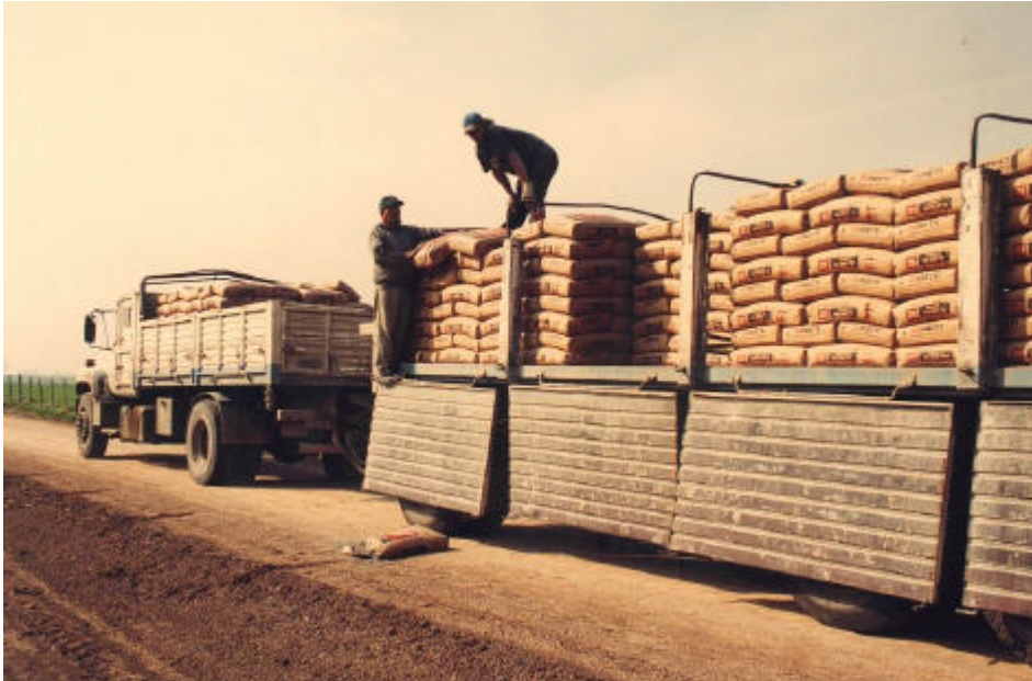
Abastecimiento del Cemento a la obra
