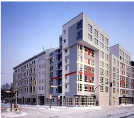
Eisenman - Edificio NC
