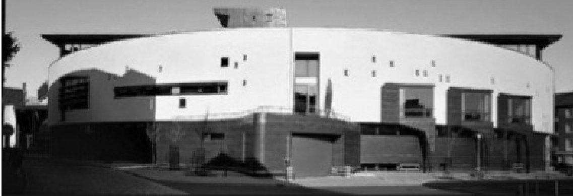
Vista de las adiciones que inspiraron la idea del edículo como apéndice del edificio
