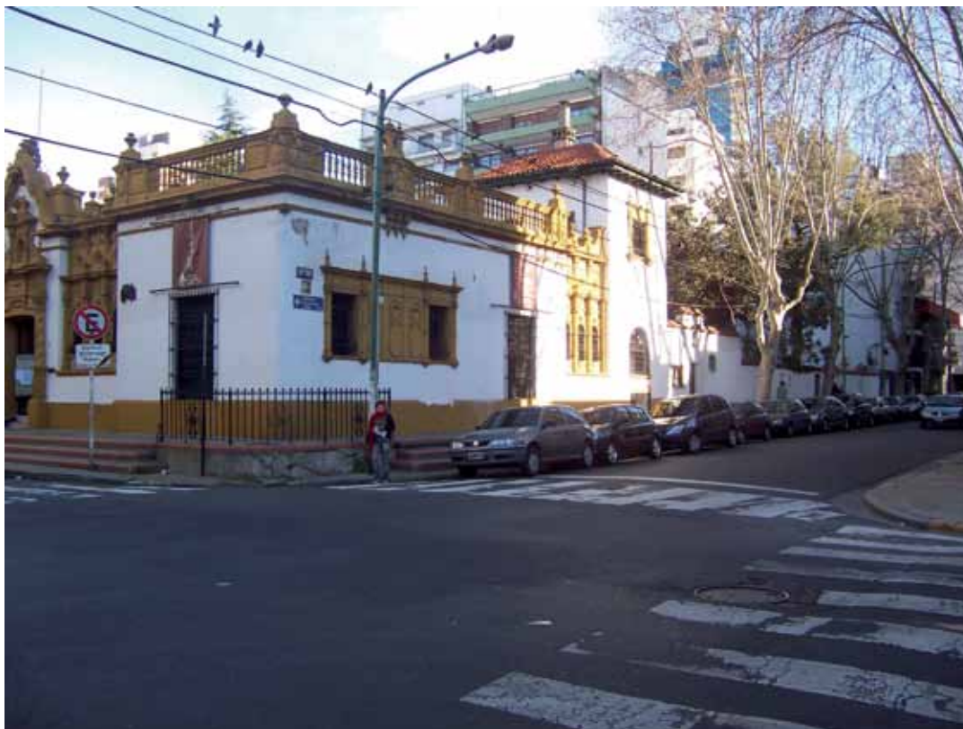
Esquina sin ochava. Los elementos de arquitectura corresponden a la estética neocolonial (Foto SK)
