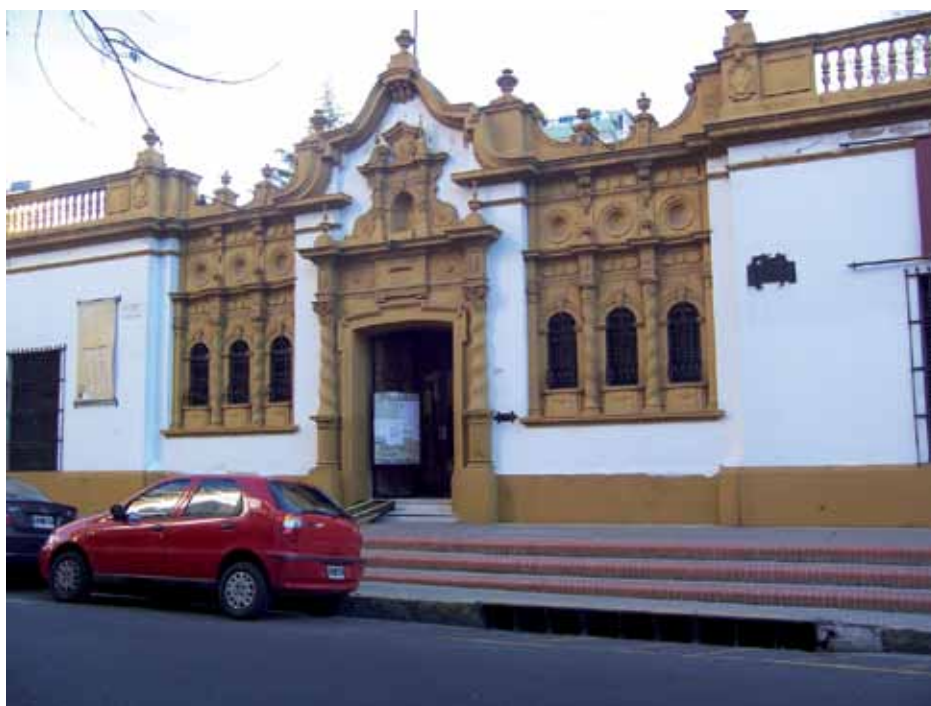
Fachada principal sobre la calle O'Higgins. Se destaca la gran puerta de acceso. (Foto SK)
