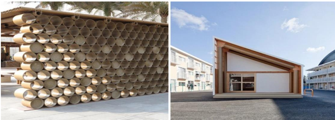
El Paper Concert Hall, del arquitecto japonés Shigeru Ban, conocida en L'Aquila como Temporary Concert Hall. Recuperado de: https://www.floornature.es/descubrir-la-arquitectura-del-premio-pritzker-shigeru-ban-9673/
