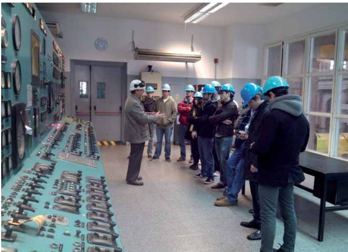
El 25 de agosto en las instalaciones de Central Puerto en Buenos Aires. Arriba: profesor y alumnos viendo los generadores de la planta. Abajo: la sala de control
