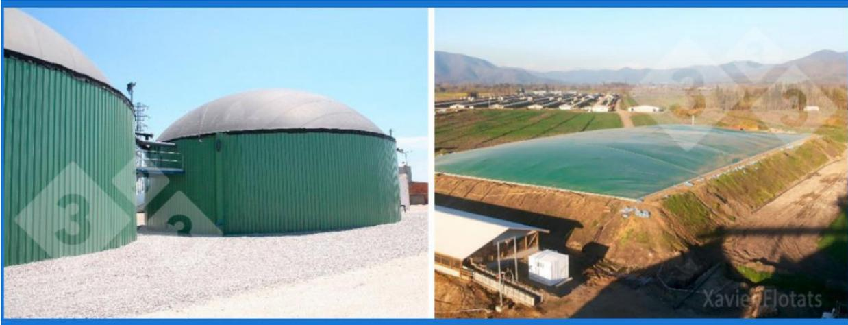
GRÁFICO BIODIGESTORES USUALES EN EL SECTOR PORCINO. IZQUIERDA: REACTOR ANAERÓBICO. DERECHA: LAGUNA ANAERÓBICA
