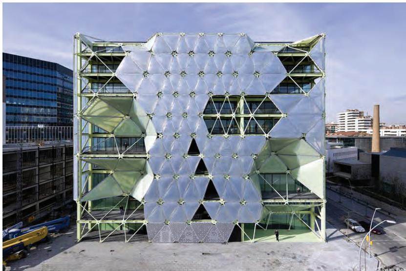
Figura 2 - Tecnología en material ETFE con captación de energía
